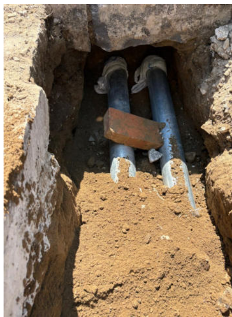
Foto esempio di posa cavidotti in attraversamenti
