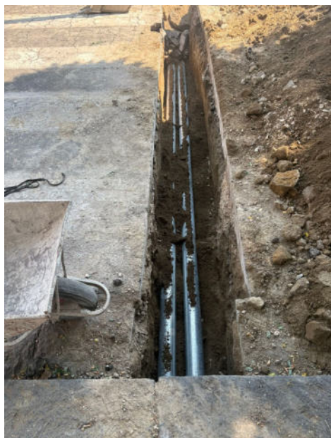
Foto esempio di posa cavidotti in attraversamenti
