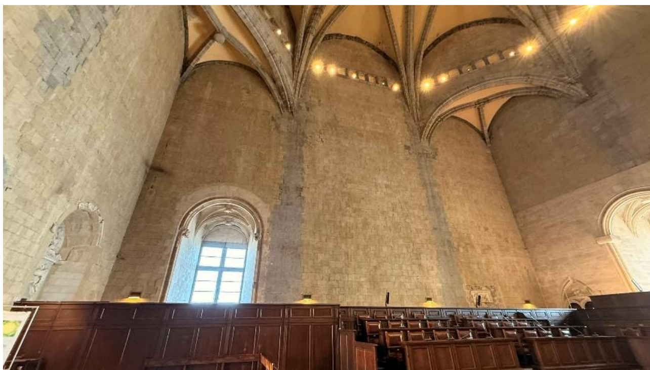
FIGURA 1 – INDIVIDUAZIONE DELLA PARETE OGGETTO DI INDAGINE
