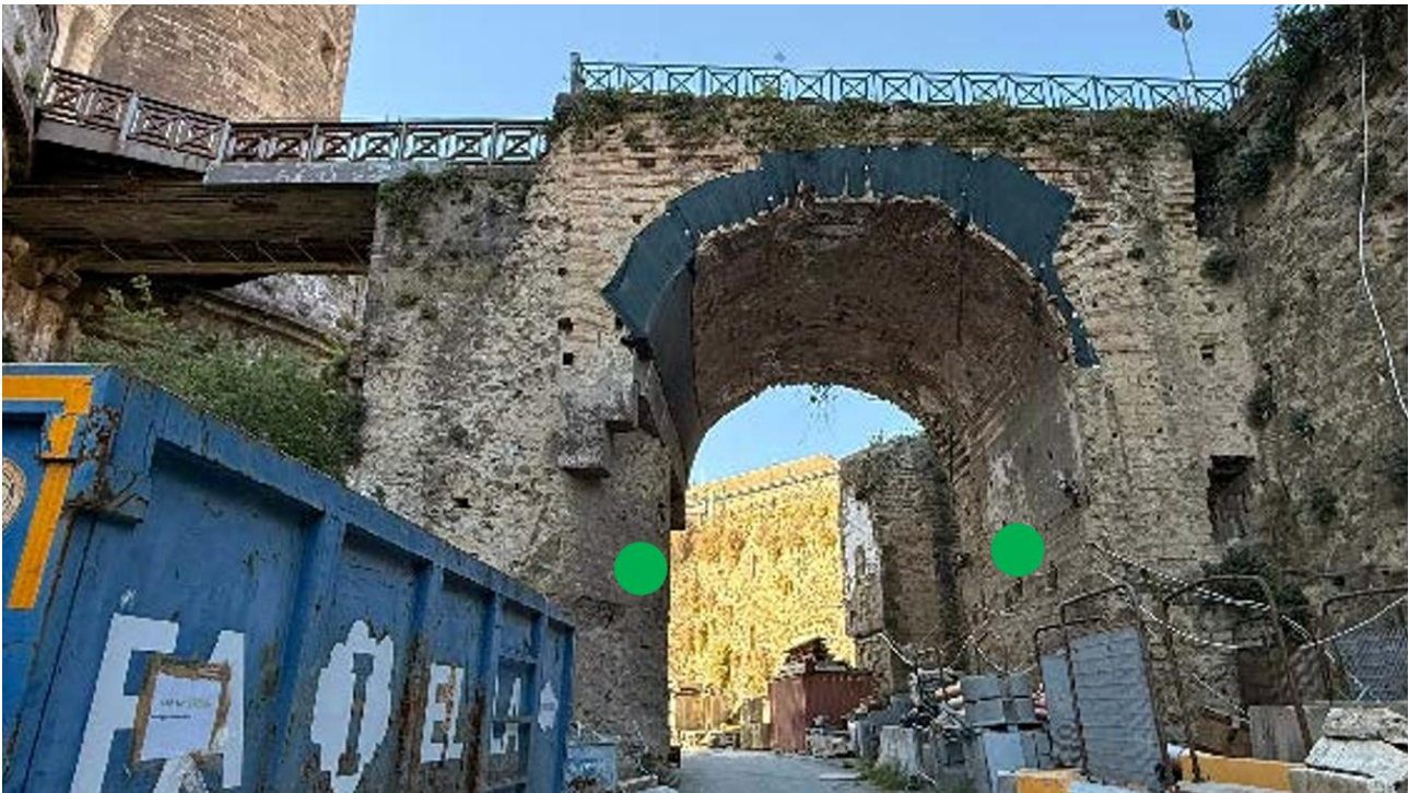
FIGURA 3 – INDIVIDUAZIONE DEI PUNTI IN CUI SARANNO EFFETTUATE LE PROVE CON MARTINETTI DOPPI
