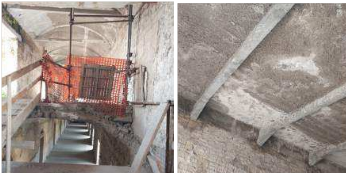
Figura 7- Alcuni dei solai del VII livello del corpo 02 di cui indagare l'effettiva capacità resistente
