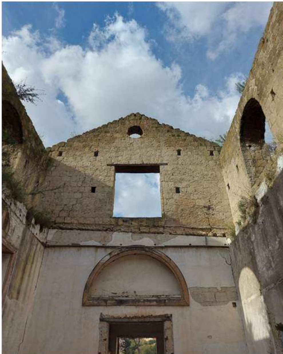
Figura 4-Intonaci con apparati decorativi al terzo piano, blocco 02; intonaci presenti nell'ex stenditoio al terzo piano
