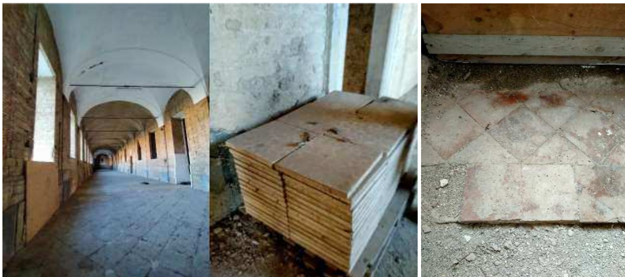
Figura 6 Il recupero conservativo delle finiture e il riutilizzo degli elementi originali
